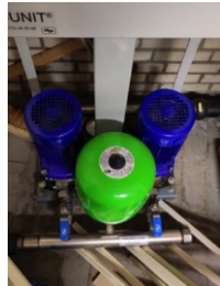
Foto's van links naar rechts: hydrofoor
