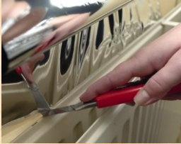
Foto: radiatorfolie aangebracht
