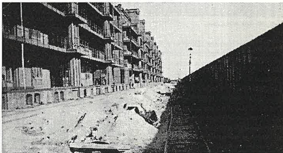
De Chinese muur in aanleg
